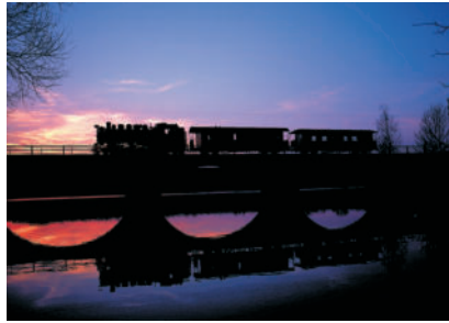
Eib 252, Talsperre Malter
